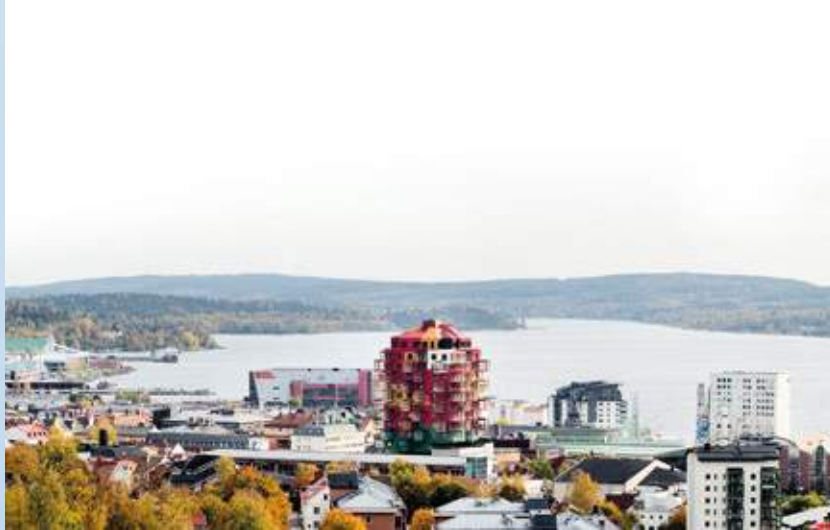
Ting 1, Örnsköldsvik, Sweden Wingårdh Arkitektkontor AB, Göteborg / Stockholm / Malmö, Sweden Completion: 2013 / KeraTwin® (K20), special colours
